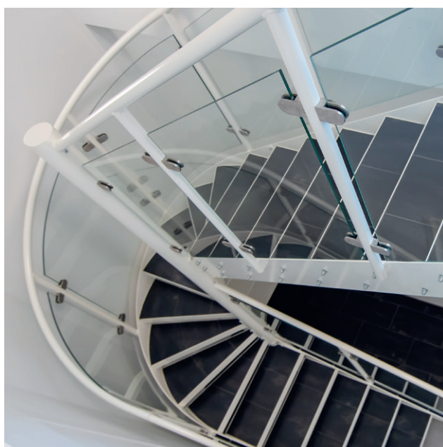
Pulverlackerad kombitrappa med glasträcke och stegbeklädnad av klinker.
